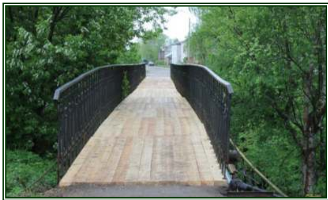
Мостик на ул. Клочихина
